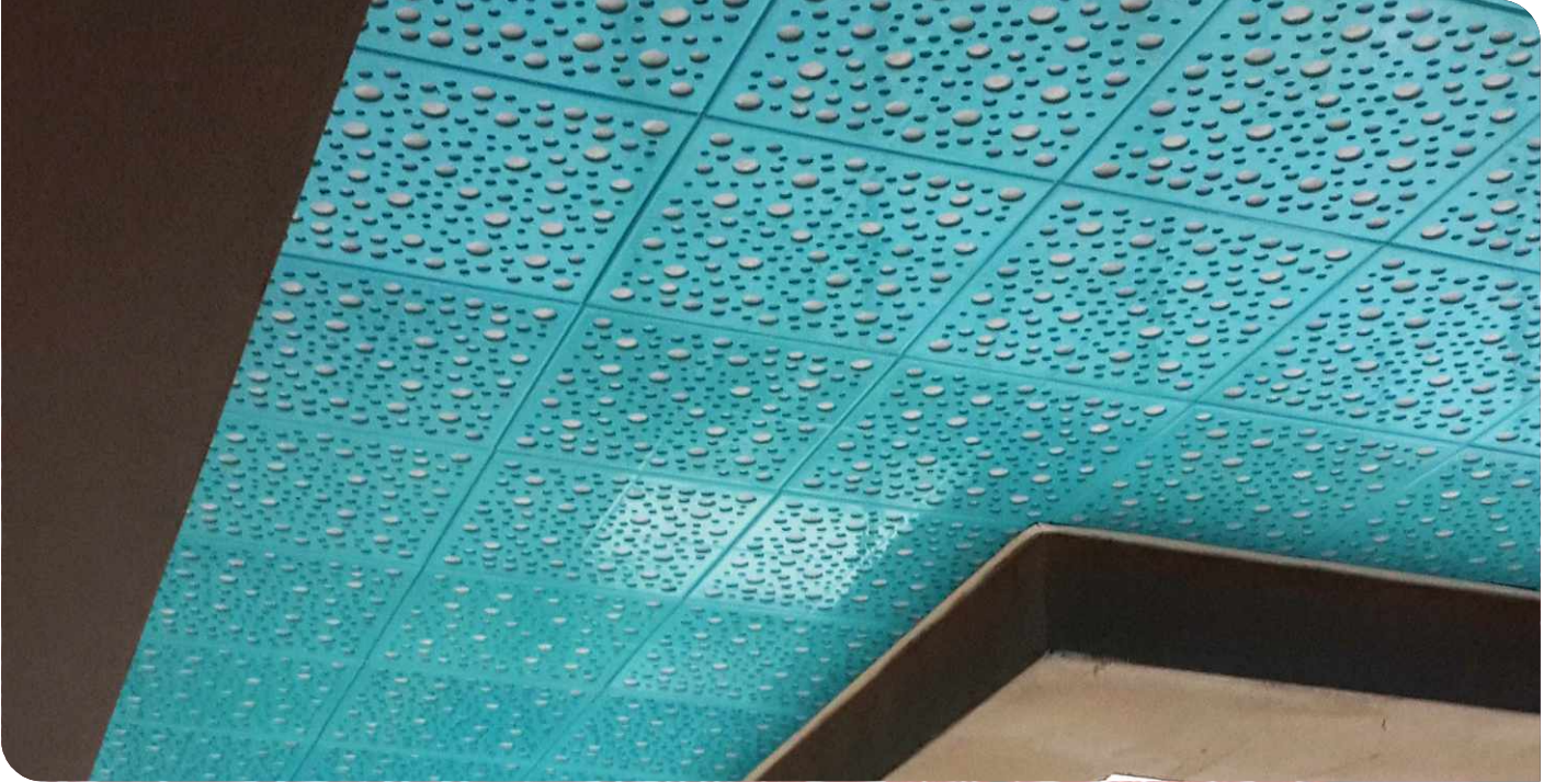
Hamam Komple Tavan Uygulama
